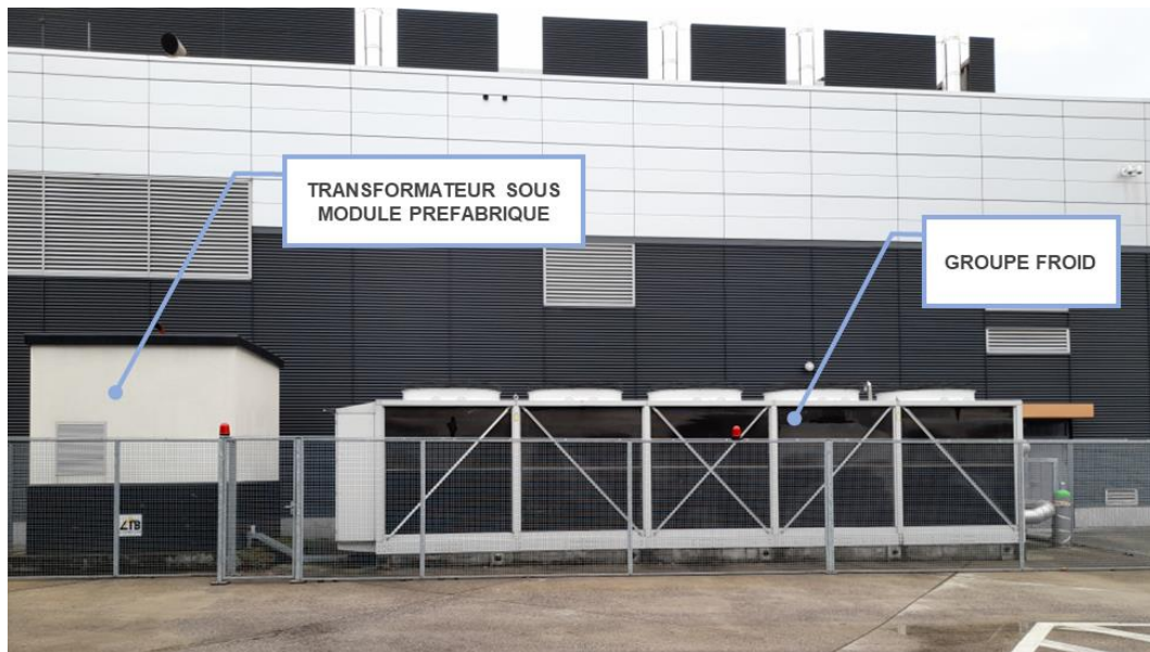
Illustration 61. Groupe froid à l'extérieur du bâtiment énergie avec transformateur 400 kVA Source. AERTEC/BAG
