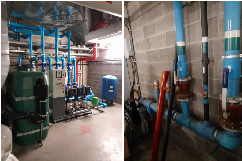
Illustration 51. Groupe surpresseur et des prises d'eau disponibles au niveau +174 Source. AERTEC/BAG
