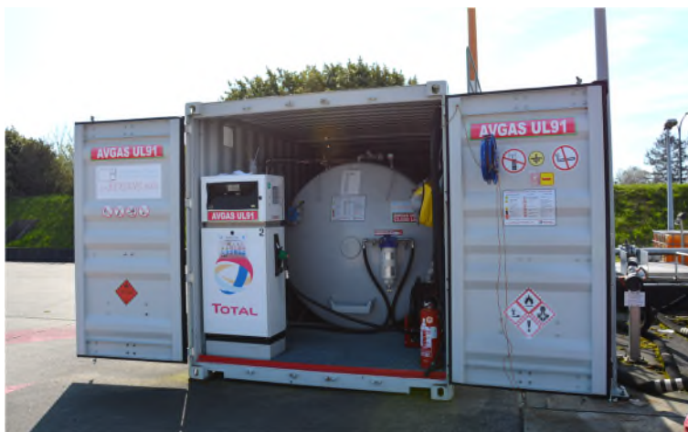
Figure 33 : Vue sur la pompe de distribution AVGAS UL91, en zone sud (ARIES, 2023)
