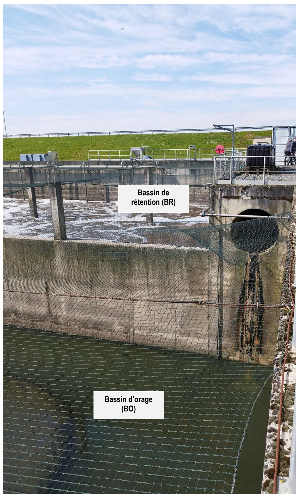
Figure 264 : Photo du bassin d'orage Nord, situé en aval du bassin de rétention – rejet R5 (ARIES, 2023)
